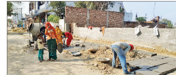
गन्नौर। बड़ी रोड पर नाले के स्लैब का निर्माण करते मजदूर।
